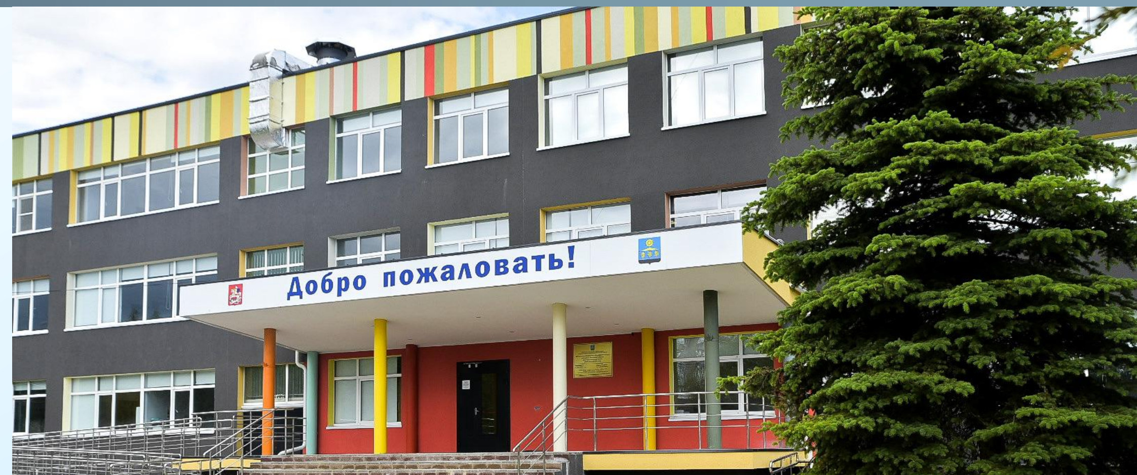
Ложковская школа после капитального ремонта
