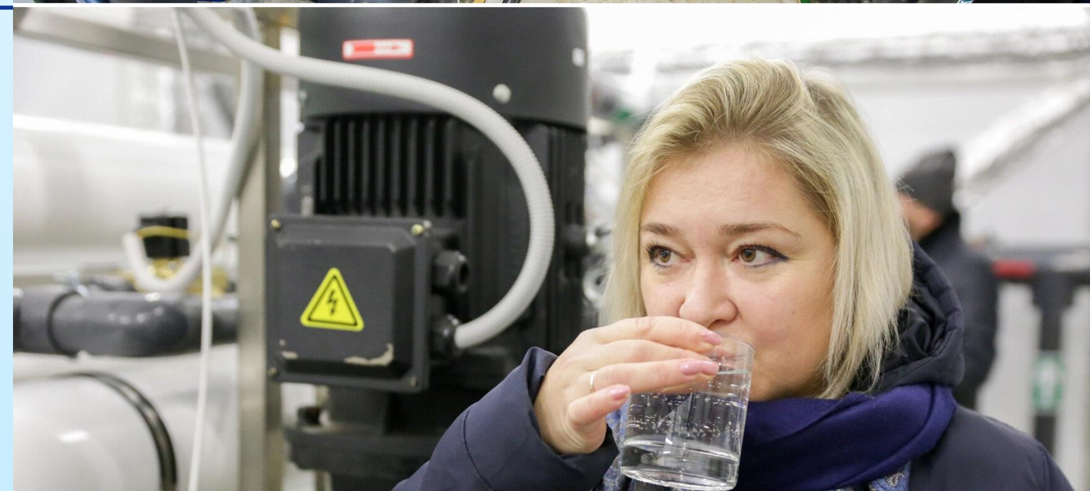
ВЗУ в деревне Новая после реконструкции
