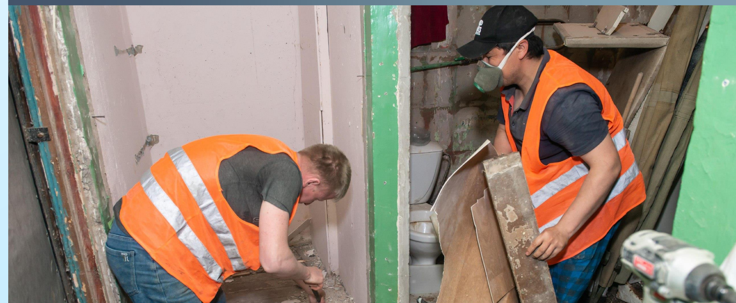
Ремонтные работы в ФАПе в Кривцово
