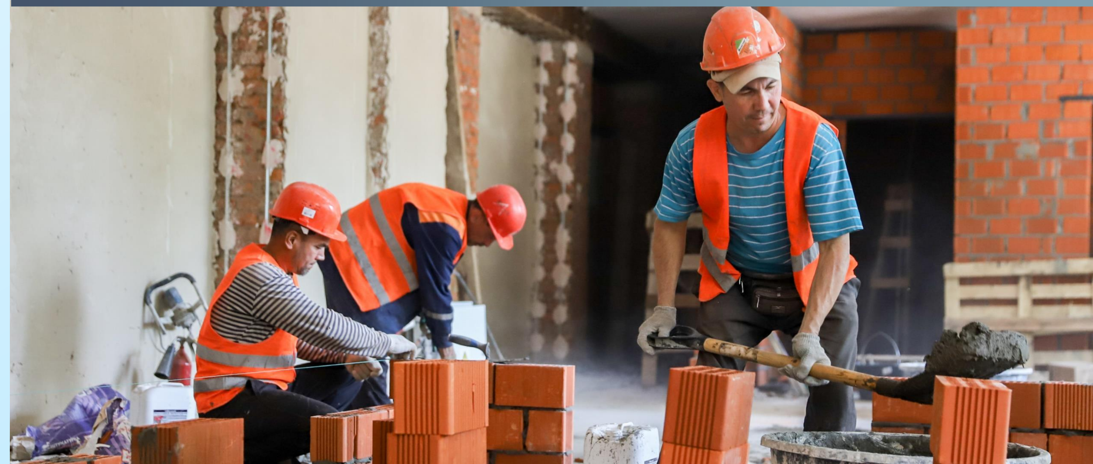
Ход капитального ремонта в детском саду №35
