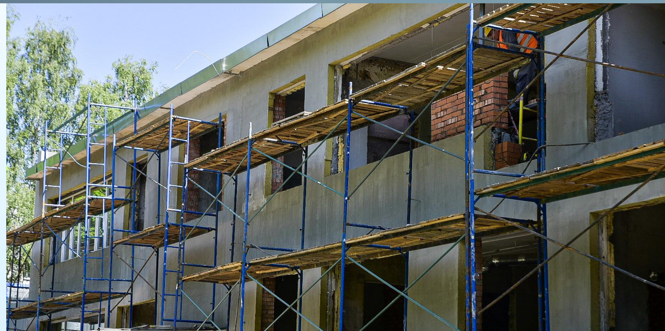
Ход капитального ремонта в детском саду №32
