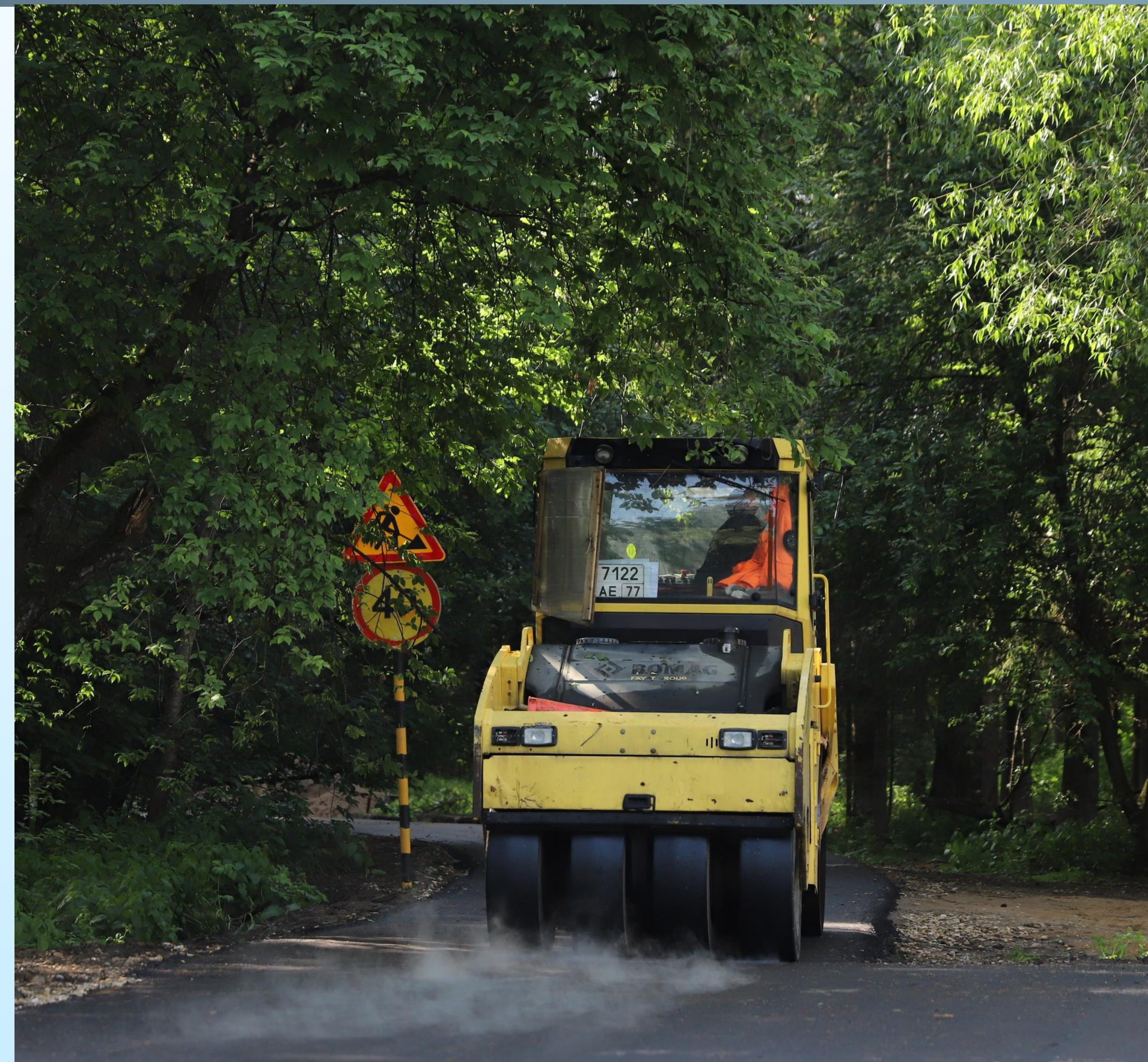
Обустройство отстойно-разворотной площадки в д. Голубое
