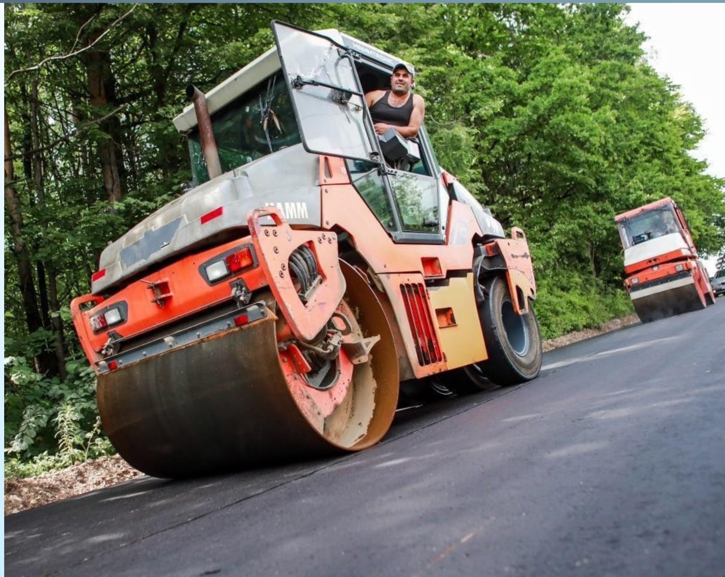
Ремонт дороги д. Гончары, ТУ Пешковское
