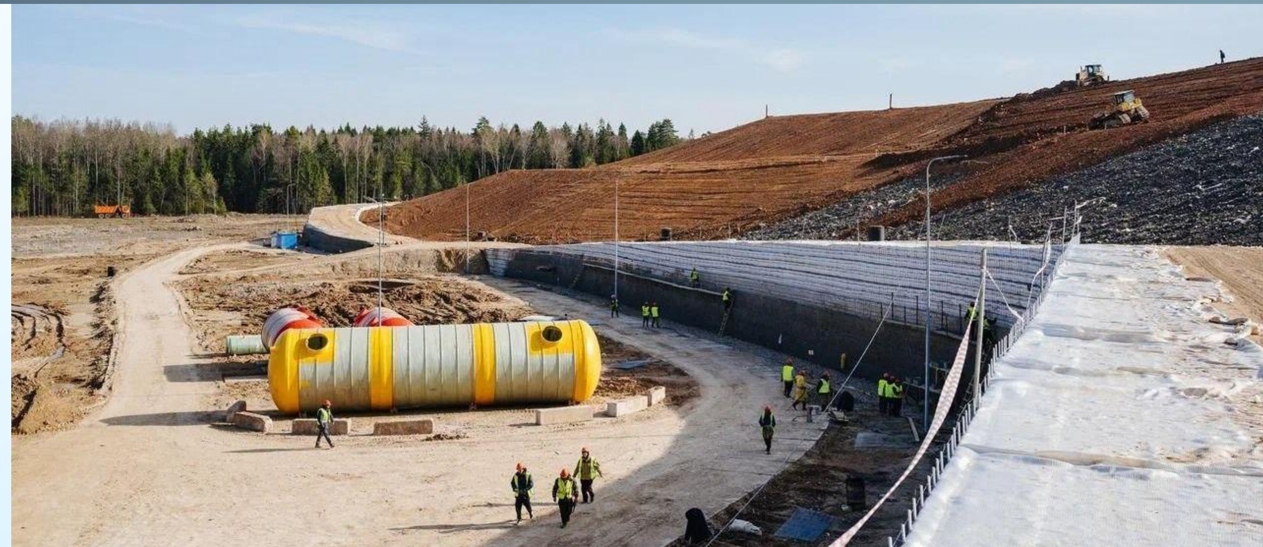
Рекультивация «генеральской» свалки в Поварово
