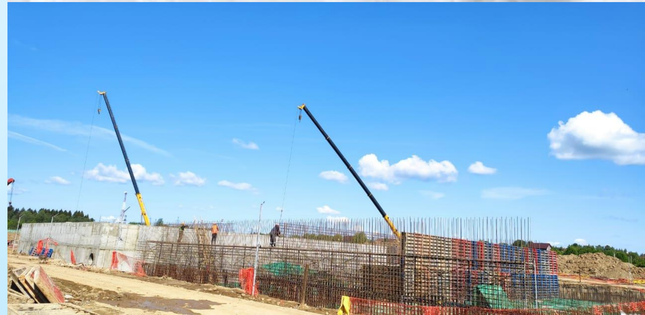
Ход строительства очистных сооружений в Осипово
