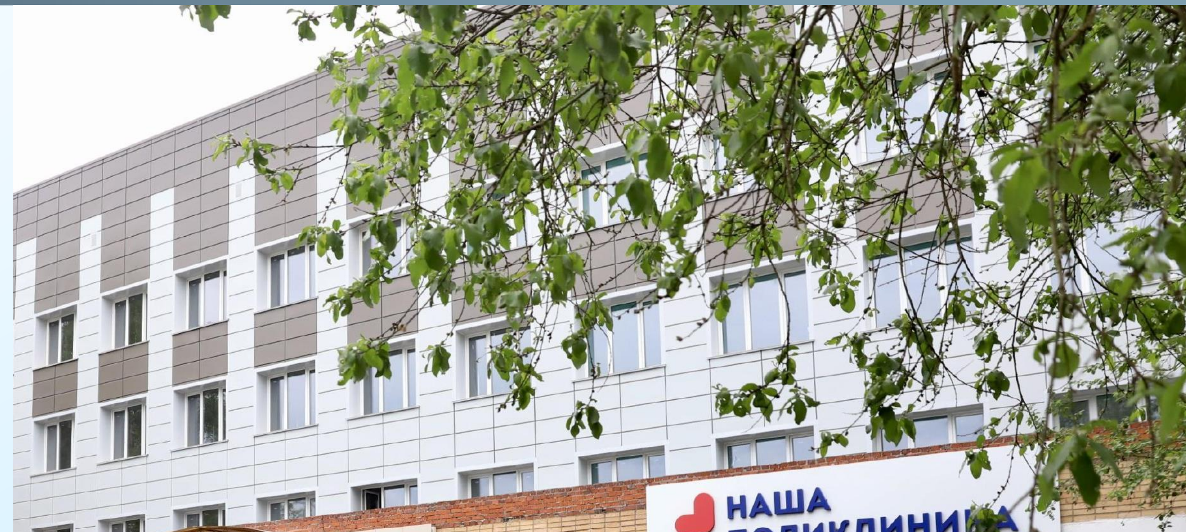
Капитальный ремонт взрослой поликлиники
